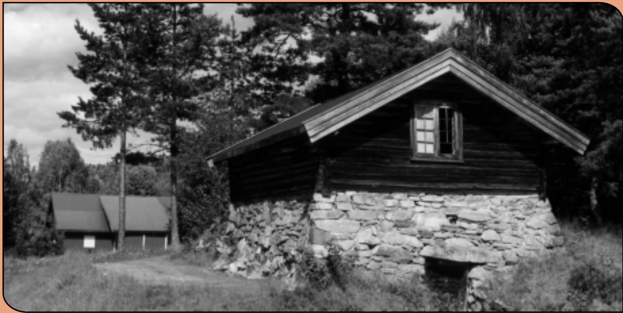
Fengslet der lensmannen Halvor Solberg satte inn naboen Gunnar Finneid, står fremdeles på Solberg. Fengslet i steinkjelleren er mørk, kald og fuktig og hadde to jernringer på veggen.
