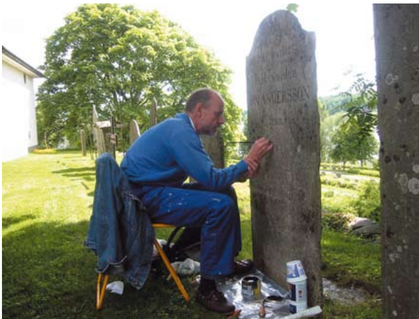
Arbeidet med restaureringen er i gang.
