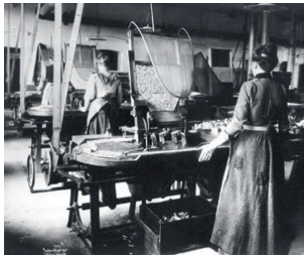
Grønvold og Nitedal Fyrstikkfabrikk. Kvinner i arbeid ved maskin for nedlegging av stikker i esker i 1907.
