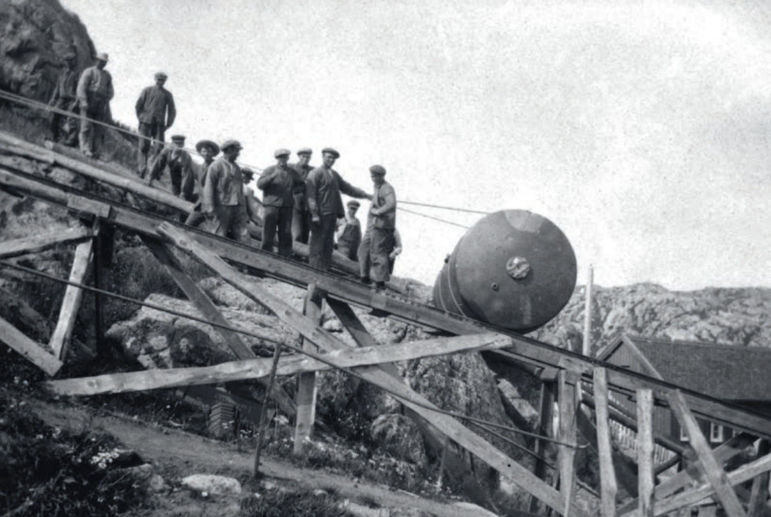
Arbeidslag fra Sunnmøre på Lindesnes i 1920. Da ble fyrstasjonen utrustet med tåkelur og her trekker fyrarbeiderne en lufttank til denne opp til det nybygde maskinhuset ved fyrtårnet.
