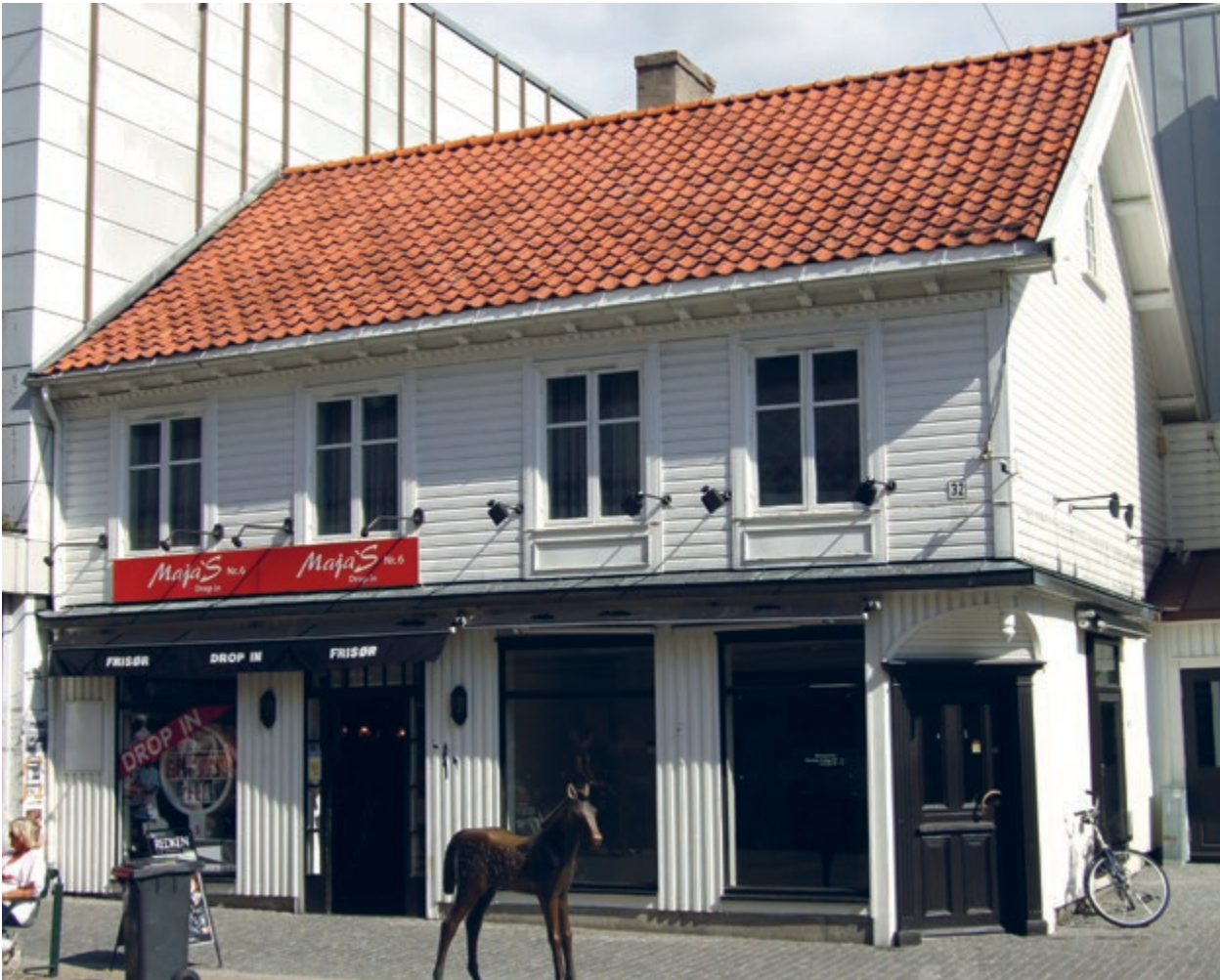
Her ser vi trehuset i Markens gate 32 i Kristiansand. Huset ble oppført ikke lenge etter bybrannen i 1734, da det forrige huset brant. I 1777 heter det for eksempel at huset hadde to etasjer, med to værelser nede med jernkakkelovn, kjøkken med skorstein og innmurt kobberkjele med bakerovn. I andre etasje var det to værelser uten ovn. I februar 2019 vedtok bystyret at huset kan rives. FOTO: ROGER TRONSTAD (2008)
