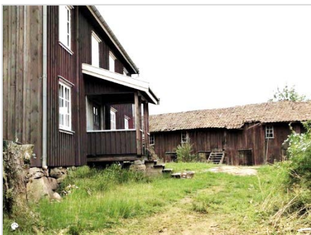
Smedhuset på Töcksfors Bruk med skuret bak
