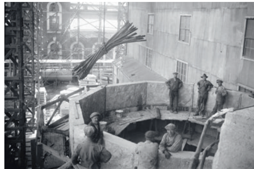
Anleggsarbeidere ved Norsk Hydro på Notodden sommeren 1917. FOTO: HANS JOHNSRUD/NIA
