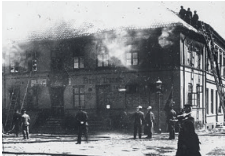
Elvegata 32–34 brant ned i 1899. I dette huset bodde mine tippoldeforeldre fra rundt 1840 og livet ut.
