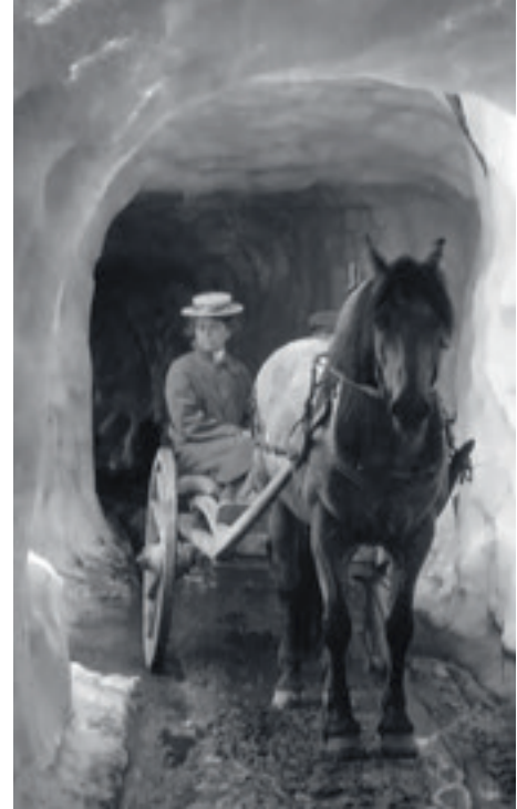
Anleggskokke på veg til Bergensbanens anlegg i juni 1906. FOTO: JOHN LANDSTAD / NORSK JERNBANEMUSEUM
