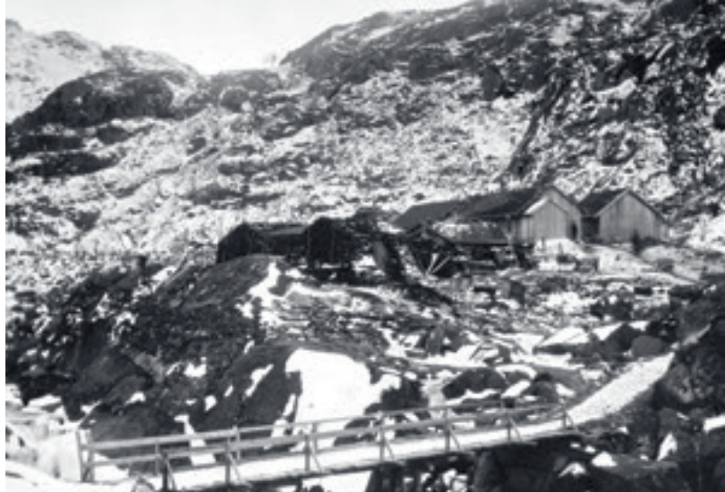
Anleggsvegens bru over Hundalselva under arbeidet på Ofotbanen. De svært enkle brakken var dårlig isolert for den kalde vinterkulda, og ble blant arbeiderne omtalt som luftslovt og fryserier. EIER: NORSK JERNBANEMUSEUM
