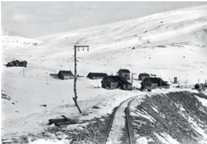
Bergensbanens anlegg ved Gravhalsstunnelen under byggingen. EIER: NORSK JERNBANEMUSEUM
