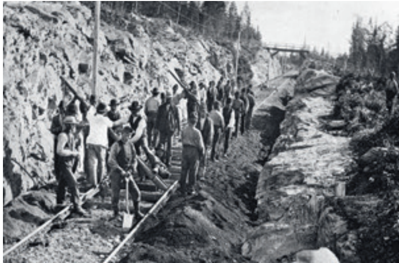
Fra ballasteringen ved Østfold- eller Meråkerbanen fra 1870- eller 1880-tallet.
