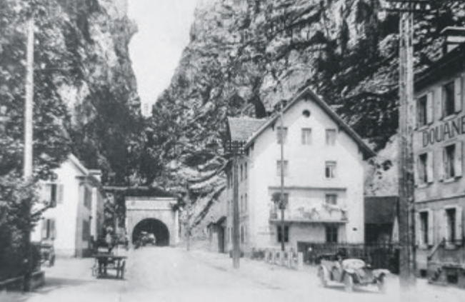
Tollhuset i Col-des-Roches. EIER: PRIVAT
